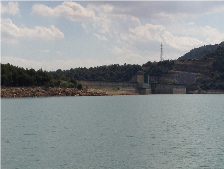
Figura 7. Vista de la presa del embalse
