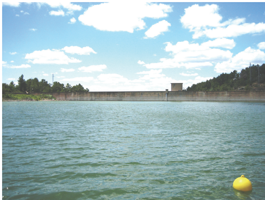
Foto 1: Vista de la presa del embalse
