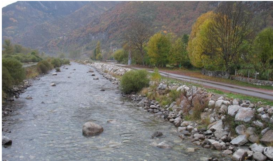
Figura 50-24. Canalización en las inmediaciones de Barruera.
