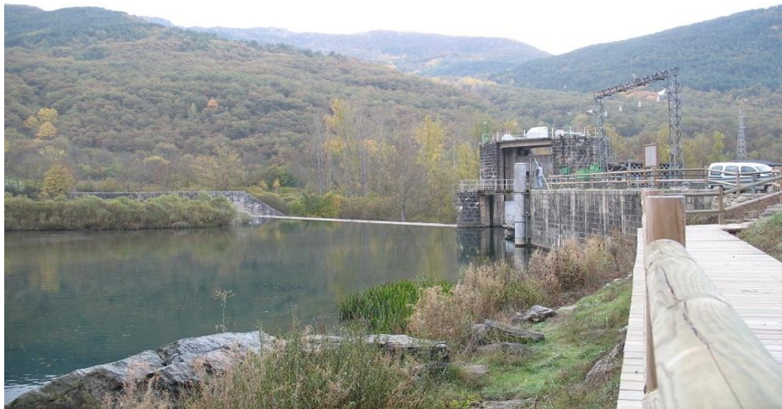
Figura 50-23. Presa de derivación de caudales aguas abajo de Llesp
