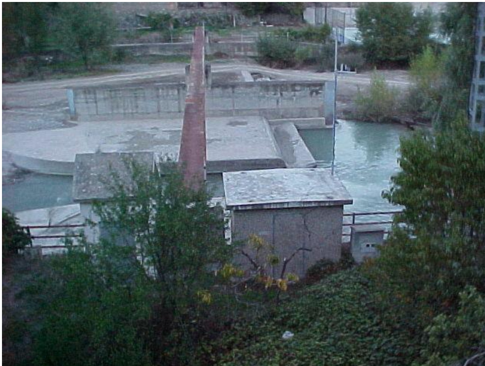
Figura 50-12. Estación de aforos de Puente de Montañana (Fotografía de la Confederación Hidrográfica del Ebro).
