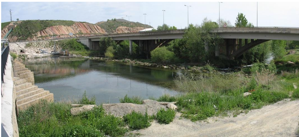
Figura 50-14. Puentes y azud de derivación en la localidad de Alfarrás.
