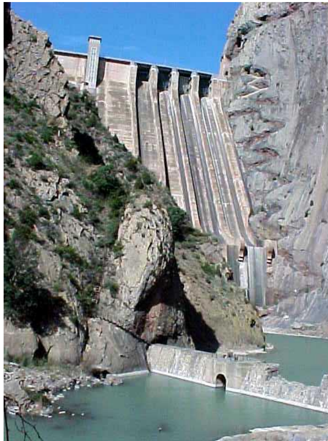
Figura 50-11. Embalse de Escales (Fotografía de la Confederación Hidrográfica del Ebro).
