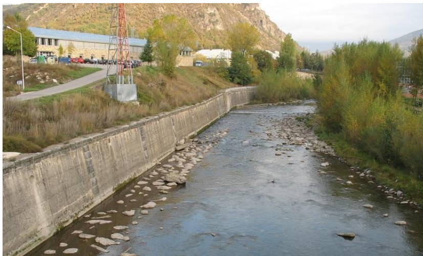
Figura 50-8. Canalización del río Noguera Ribagorzana.
