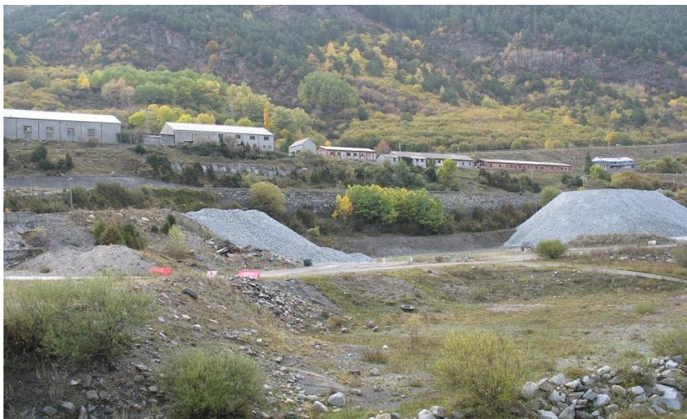
Figura 50-3. Llanura de inundación alterada en las inmediaciones de la localidad de Aneto.
