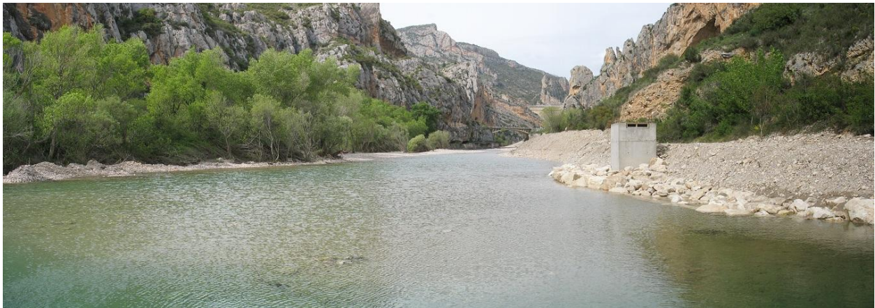
Figura 50-15. Dragado del cauce aguas abajo del embalse de Santa Ana.
