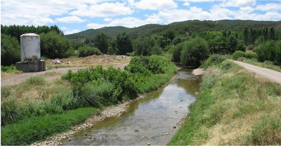
Figura 40-7. Río Jiloca en las inmediaciones de la localidad de Fuentes de Jiloca. Motas defensivas coronadas por pistas agrícolas.
