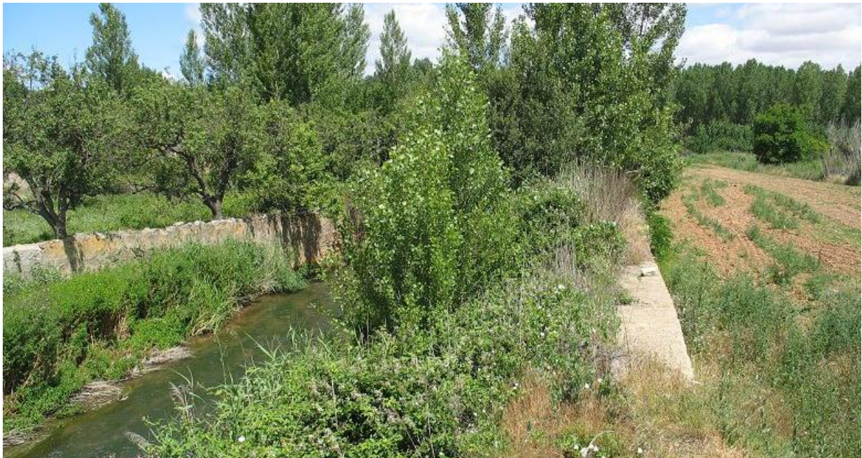
Figura 40-8. Río Jiloca en San Martín del Río. Muros laterales muy cercanos al cauce.
