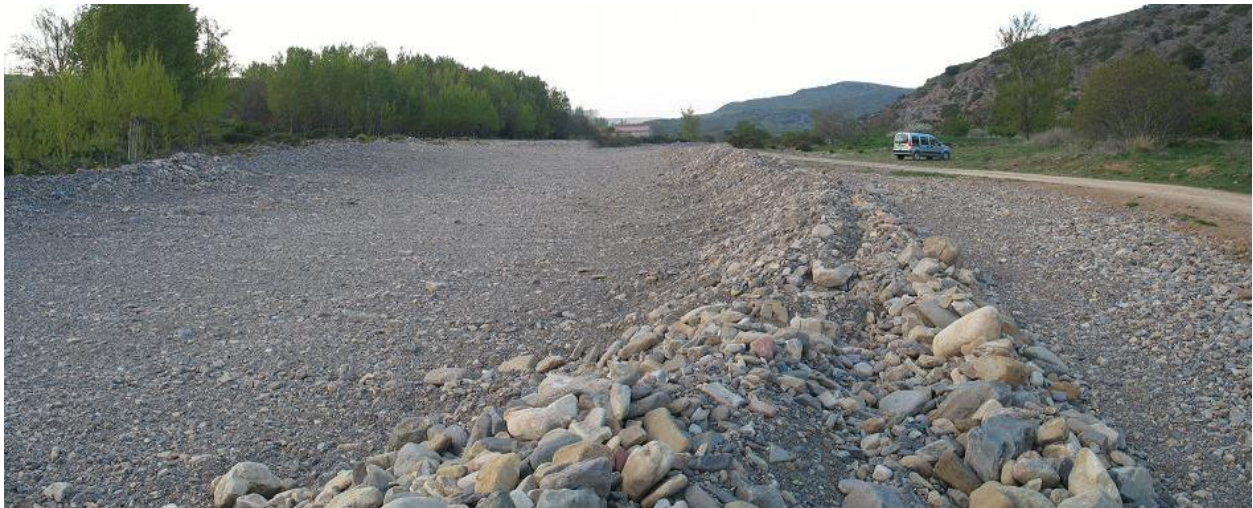
Figura 31-6. Cauce dragado, defensas de margen y alteraciones en la ribera del río Huecha en el entorno de la localidad de Alcalá del Moncayo.
