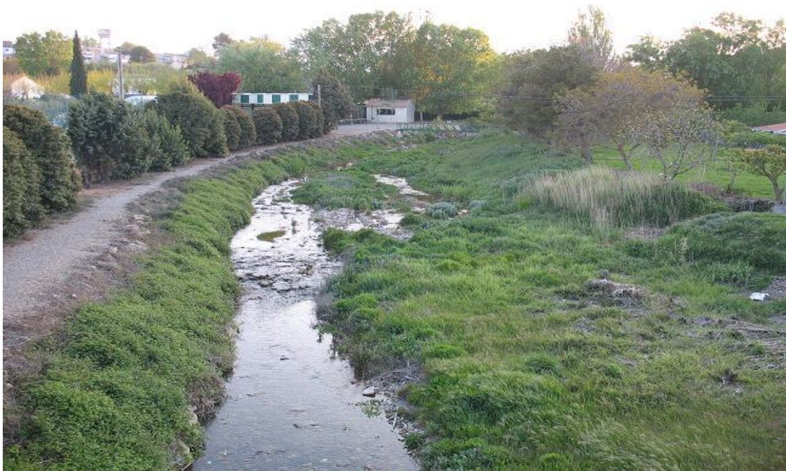
Figura 31-8. Cauce con defensas laterales en las inmediaciones del núcleo de Ainzón.
