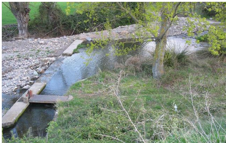
Figura 31-4. Pequeño azud en el cauce del río Huecha en las inmediaciones de la localidad de Añón.
