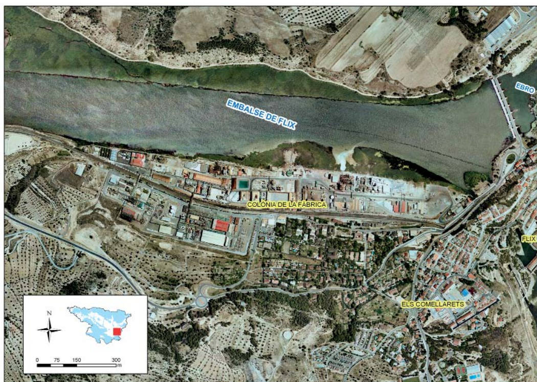
■ FIGURA 5.3.40 SITUACIÓN DEL ÁREA DE INFLUENCIA DE LA CONTAMINACIÓN. ZONA 106-02
