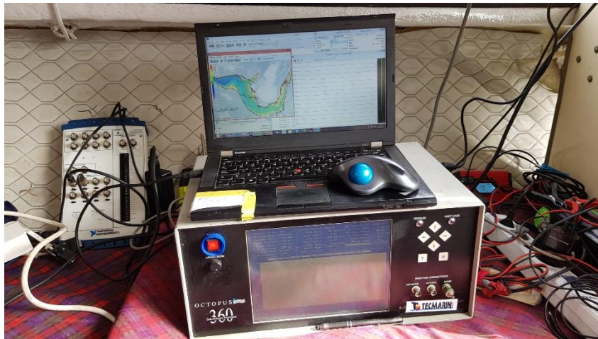
Figura 50 Instalación de equipos a bordo.
