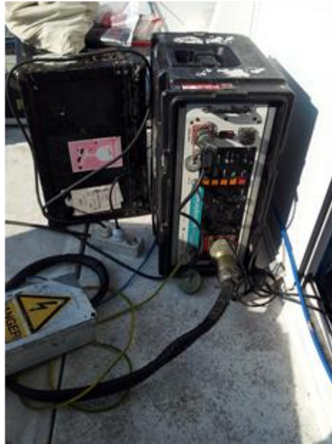
Figura 40. Fuente de alimentación del emisor sísmico.
