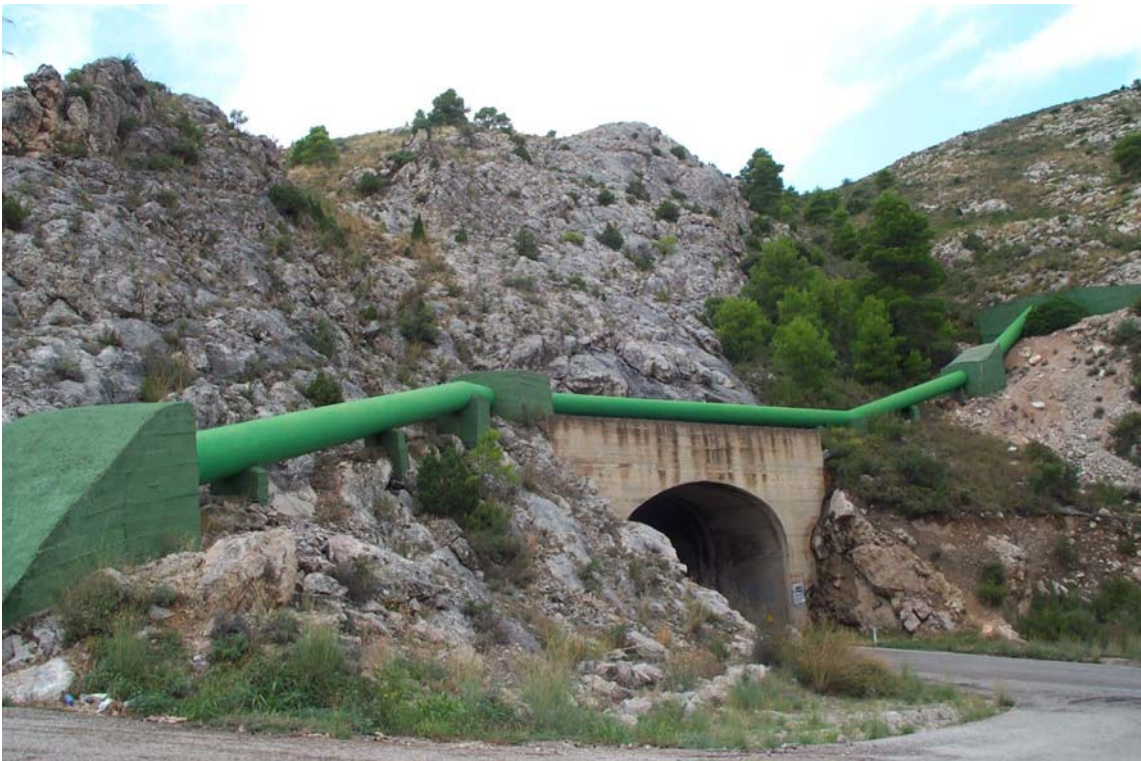
Impulsión de agua hacia la central térmica de Andorra
