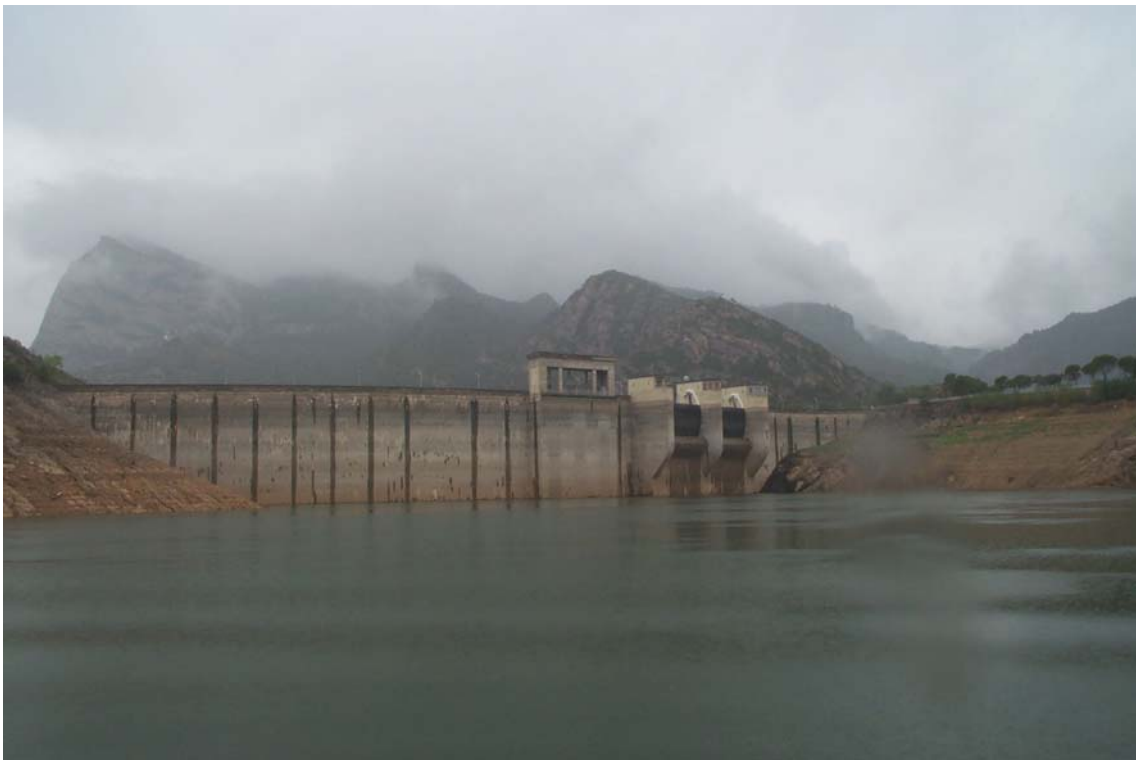
Presa de Oliana
